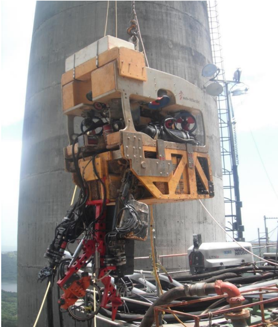
Figure 5: ROV com braços manipuladores para a remoção e instalação das grades
